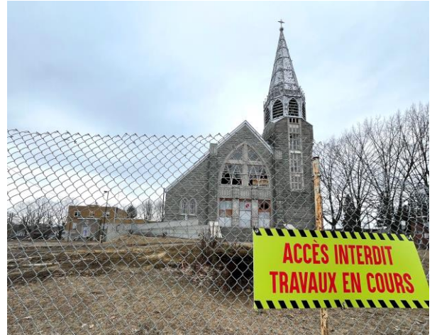
Les travaux de démolition de l'église Sainte-Madeleine de Trois-Rivières débiteront sous peu.
